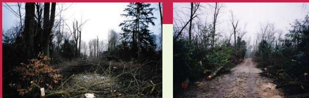
Fig.13 : L'ouverture des allées est incontournable pour accéder aux parties détruites.
