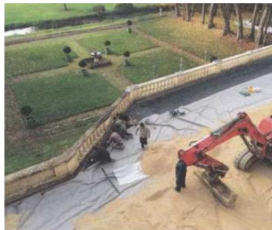
Vues du mur de soutènement restauré sur plus de 250 m et des travaux pour l'étanchéité de la terrasse en 2014 © M. Lelandais
