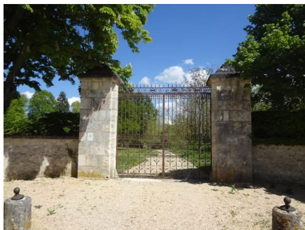
Vue de la grille d'entrée depuis la rue du Château
