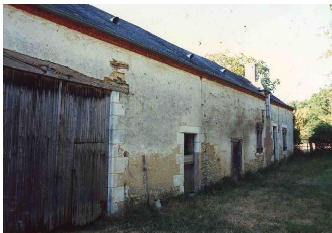
Vue de la maison à l'origine
